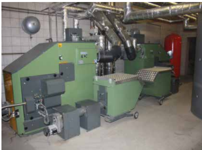
HDG:s utmatning med hydrauliska skrapor lämpar sig särskilt väl vid mycket stora behov. Här används den tillsammans med två HDG Compact 200.
