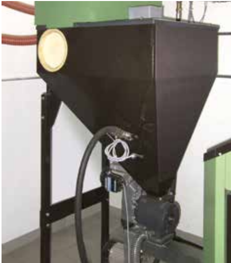
Sugbehållaren på HDG:s sugsystem för pellets har kapacitet för en volym på upp till 100 kg pellets.
